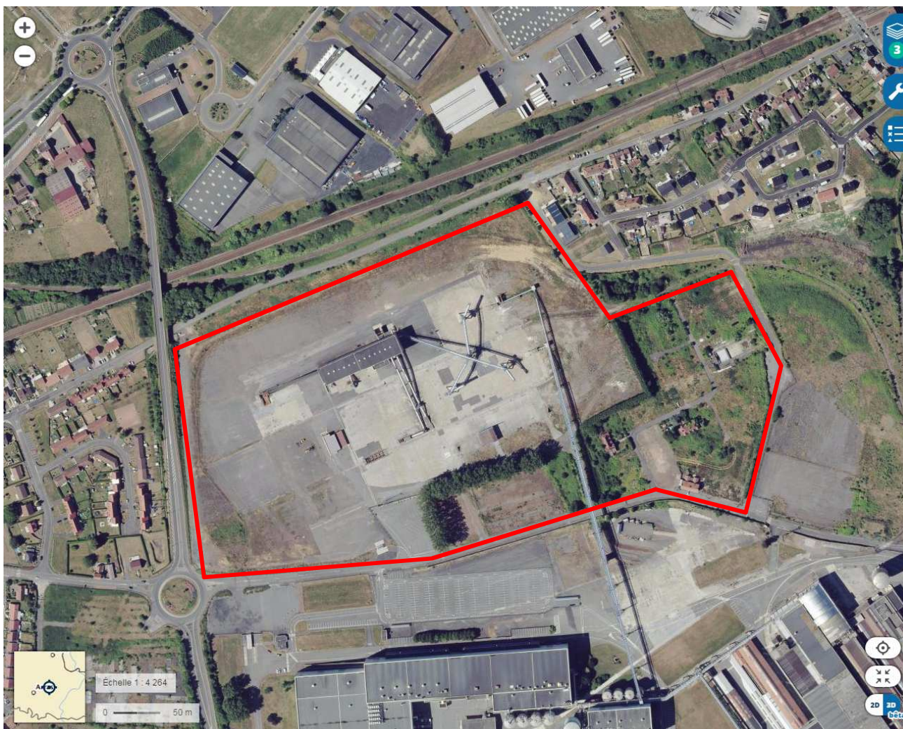
Figure n°1 : Vue aérienne récente du site (source : Géoportail le 20/04/2017)
